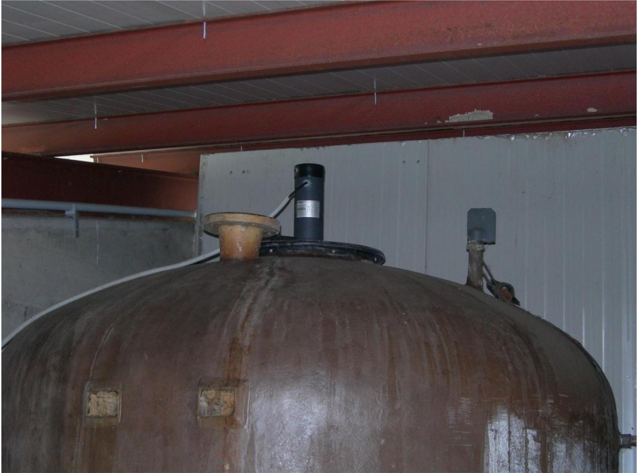
**DCU04 installato su vasca vetroresina di 6mt contenente policloruro di Al**
